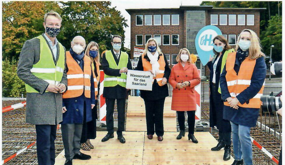
Es ist soweit: Die erste Wasserstoff-Tankstelle im Saarland wird gebaut. Repräsentanten aus Politik und Wirtschaft zeigten sich bei der Grundsteinlegung hoch zufrieden mit der nun voranschreitenden Realisierung des Projektes.
